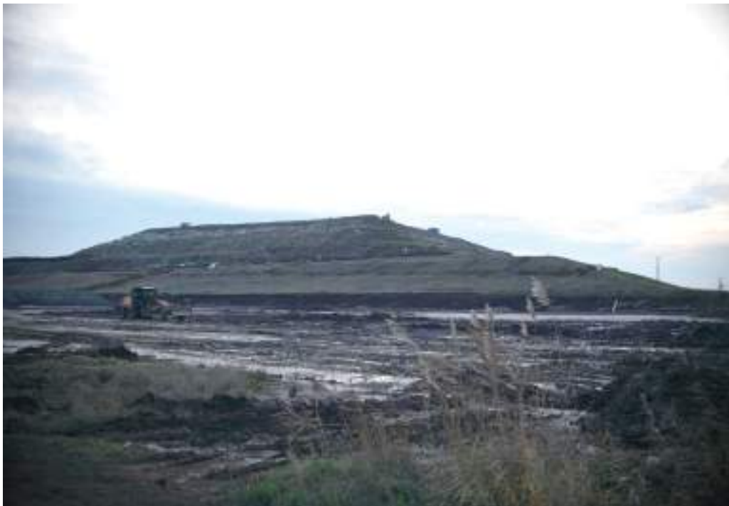
Közvetlenül a Sándorfalvi úti hulladéklerakó mellett épül az új kétkazettás lerakó, amely összesen a mostanival. Fotó: Szabó Luca.
