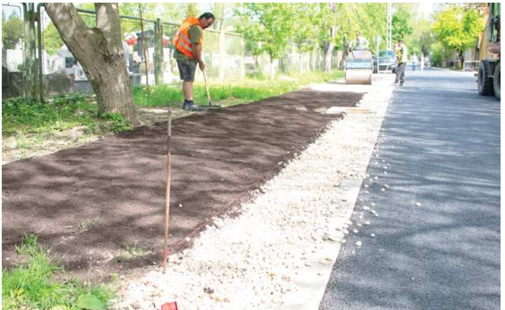
Az utolsó simítások a Temető utca korszerűsítésénél. Lapzártánk után megnyitották a forgalom előtt a megújult útszakaszt. Fotó: Szabó Luca
