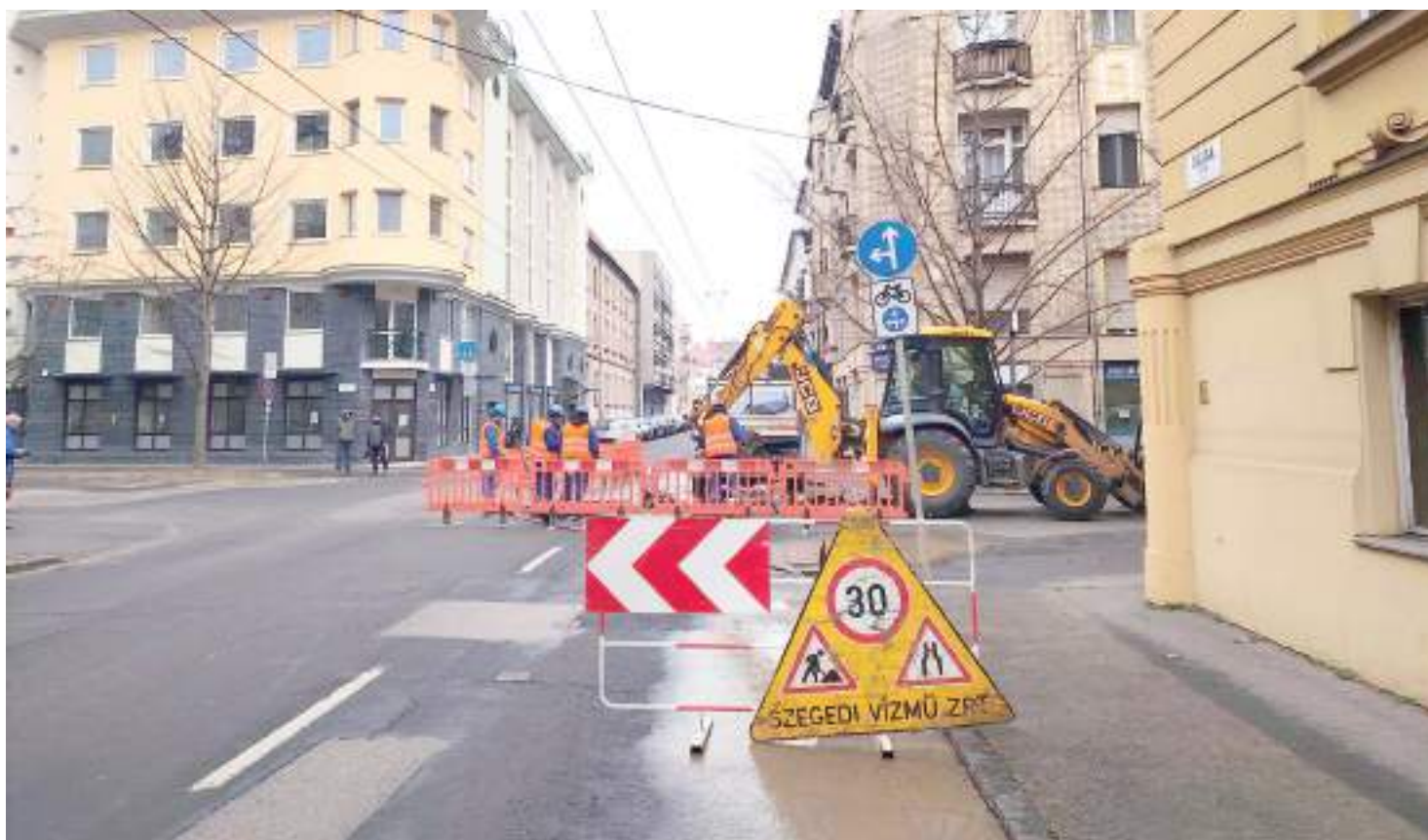
Írásunk a 3. oldalon A tervezett vízvezetékcsere a Dózsa György utca és az Arany János utca kereszteződésében kezdődött el.
