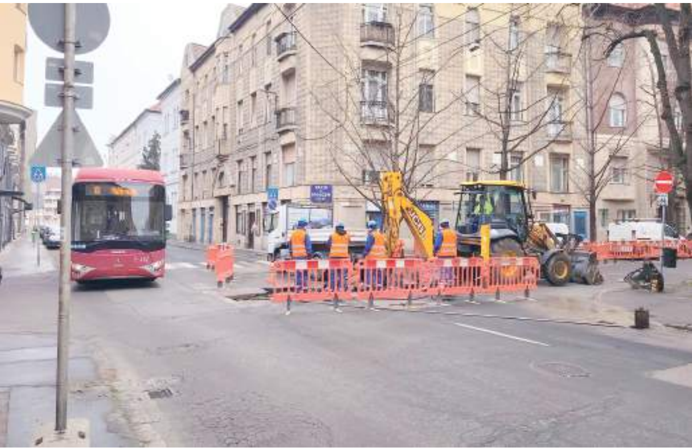
A Dózsa György utcai vízvezeték- és burkolatfelújítás miatt forgalom- és parkolási korlátozásra kell számítaniuk az arra közlekedőknek.
