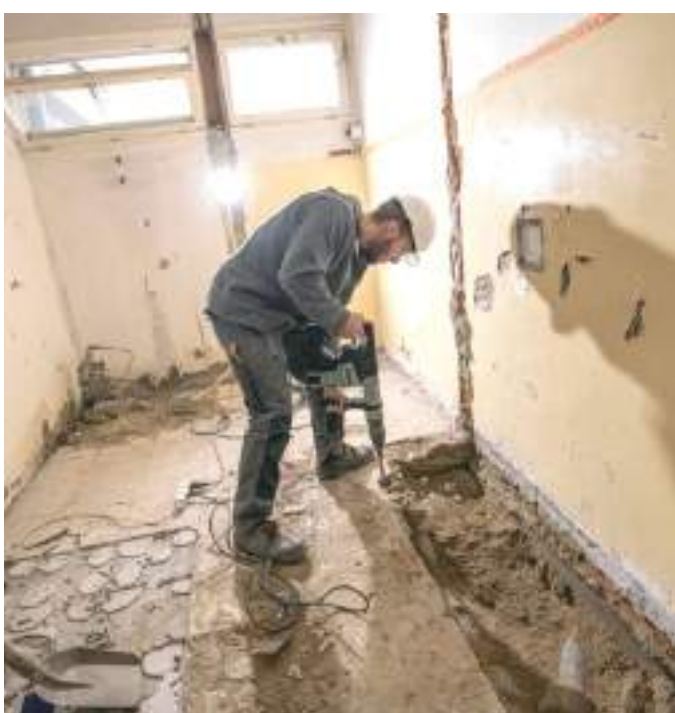
Bontási munkálatokkal kezdődött el az Eszperantó utcában a Senior Center felújítása. Fotó: Iványi Aurél
