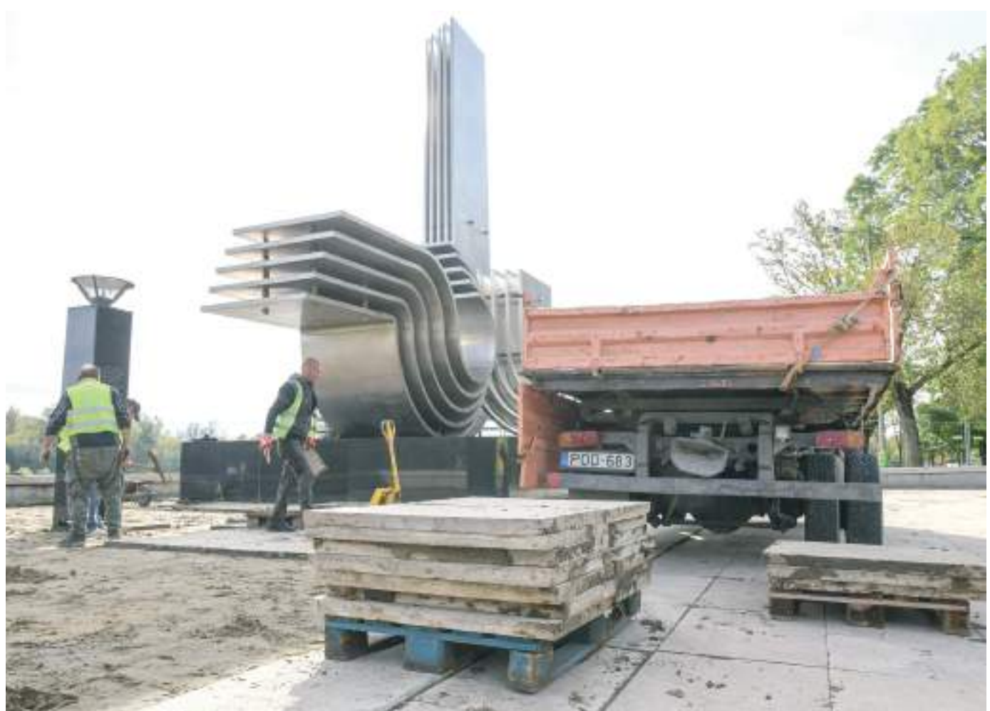
Feltörik a balesetveszélyes mészko burkolatot, a helyére igényes új, teherbíró burkolat készül. Fotó: Kuklis István
