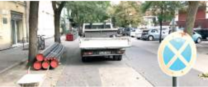
A régi azbesztcement vezeték helyére új, polietilén műanyag vezeték kerül.
