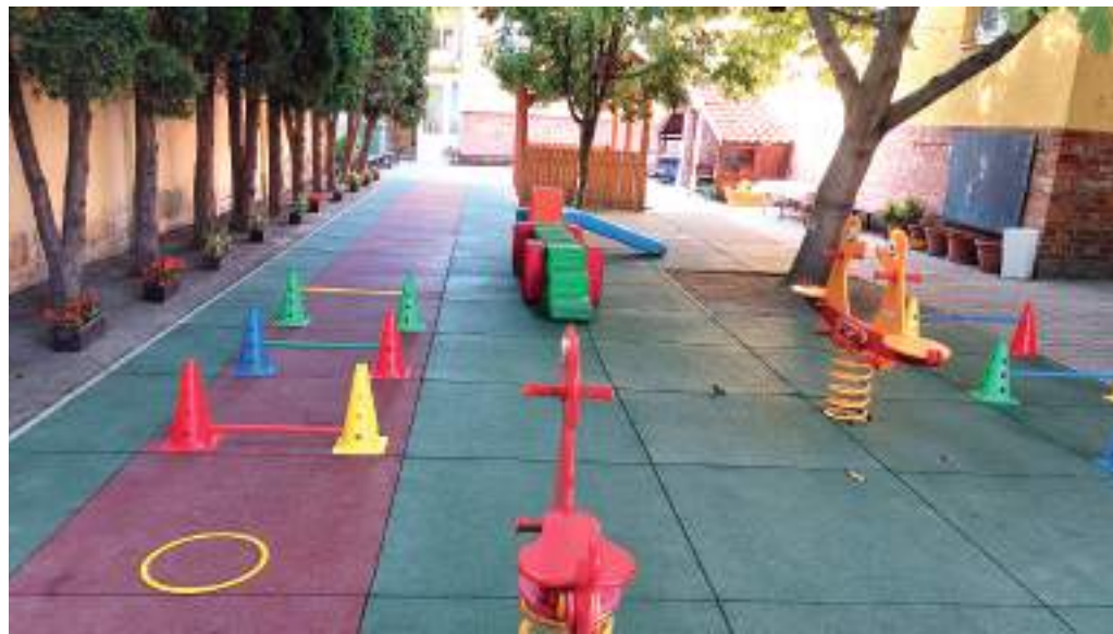
Az óvoda felújított udvara. Forrás: Koromné Fenyvesi Rózsa FB-oldala
