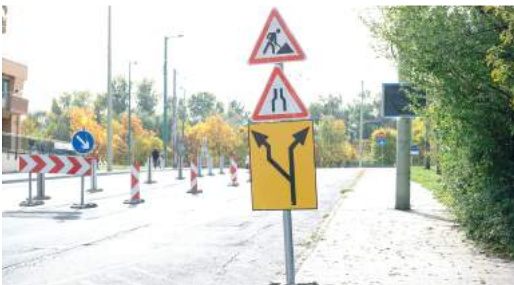
Már kitáblázták a munkaterületet. Lapzártánk után kezdődött az útfelújítás az Etelka soron.
