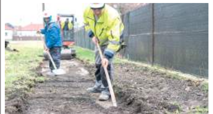
Folytatják a járdaépítést a szőregi temető előtti szakaszon. Fotó: Iványi Aurél
