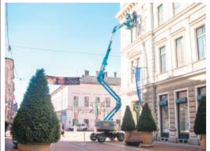
Már rögzítik a napvitorlák tartószerkezetét a Kárász utca Széchenyi tér felőli szakaszán. Fotó: Szabó Luca
