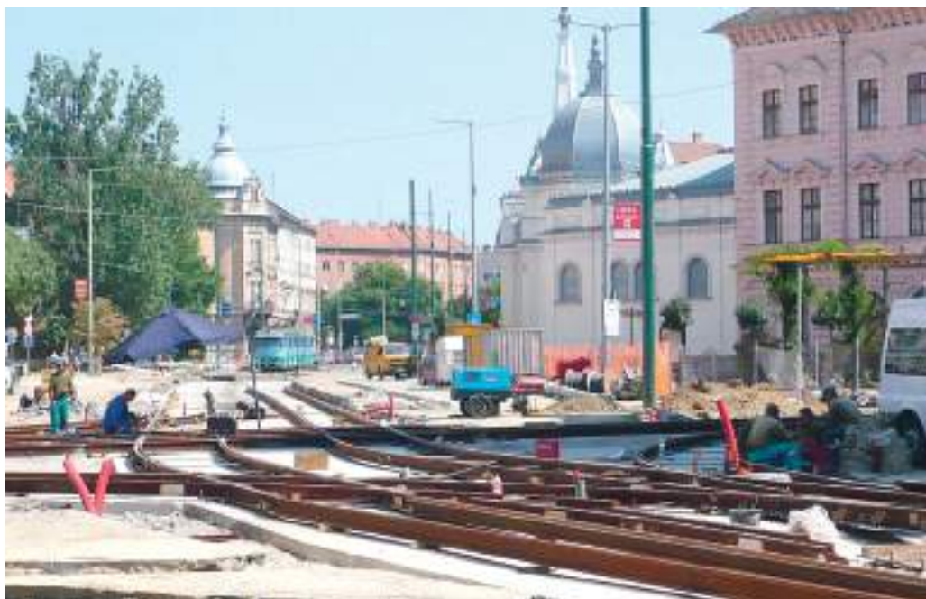
Villamospálya-rekonstrukció Szegeden, 2008-ban.
