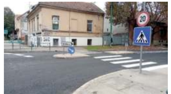
A körzet legnagyobb önkormányzati fejlesztése idén a Veres ács utcai ivóvízvezeték-csere és aszfaltozás volt.
