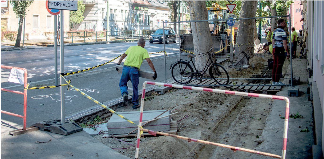
Elkezdtek a felújítási munkát a József Attila sugárúton. Első lépésként felbontották a járdát a körút és a Szent Miklós utca között. Fotó: Szabó Luca
