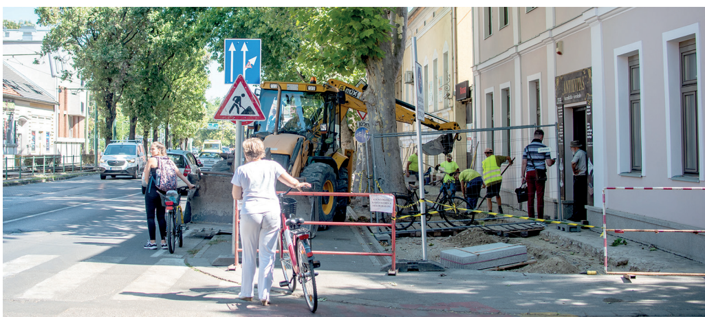
A József Attila sugárút nagykörút és Szent György tér közötti szakaszán két ütemben végzi a munkát a kivitelező. Fotó: Szabó Luca
