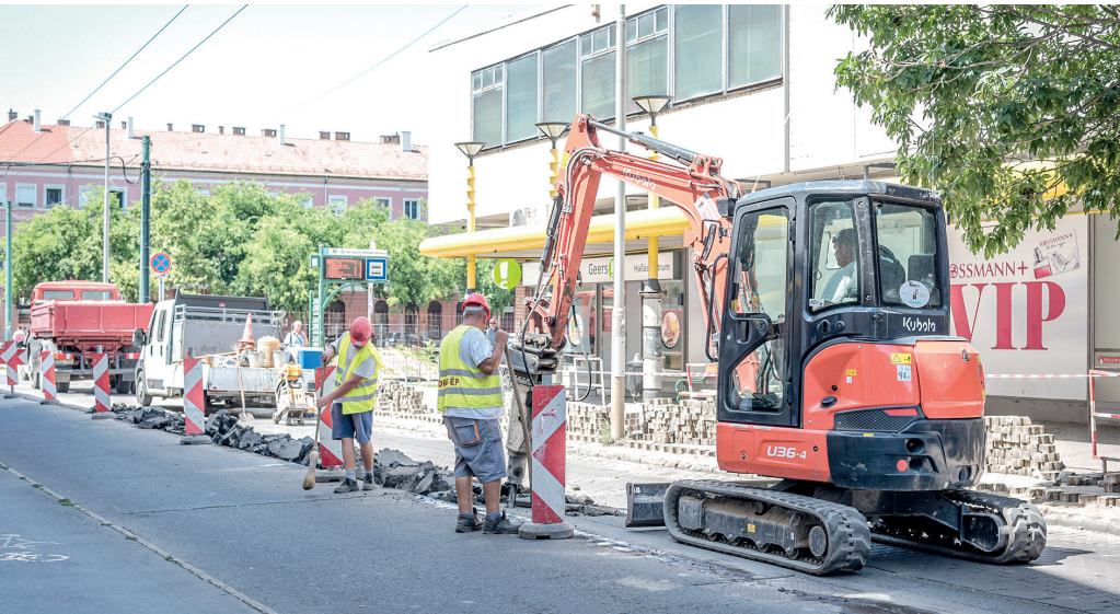
Bazaltbetonra cserélik a megsüllyedt burkolatot a Mikszáth Kálmán utcai Centrum-megállónban. Fotó: Iványi Aurél
