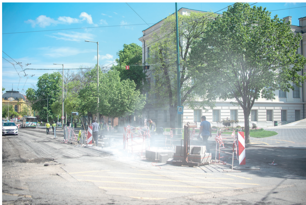
A Stefániát előreláthatólag most hétfőig aszfaltozzák, és hétfőtől ismét két irányban járható. Fotó: Szabó Luca
