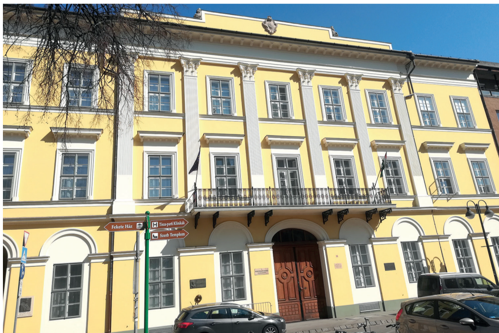
A Somogyi utcai épületben gyakran megfordult Gárdonyi, a Szegedi Híradó szerkesztősége a szomszédos Oskola utcai épületben működött.
