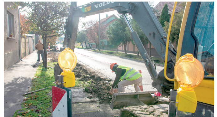
Bontják az útszegélyt. Megújul a Csap utca Irinyi és Solya utca közötti szakasza. Fotó: Szabó Luca
