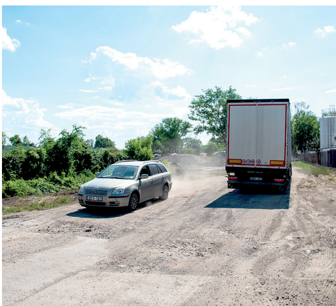
A Házgyári út a felújítás előtt. Fotó: Szabó Luca
