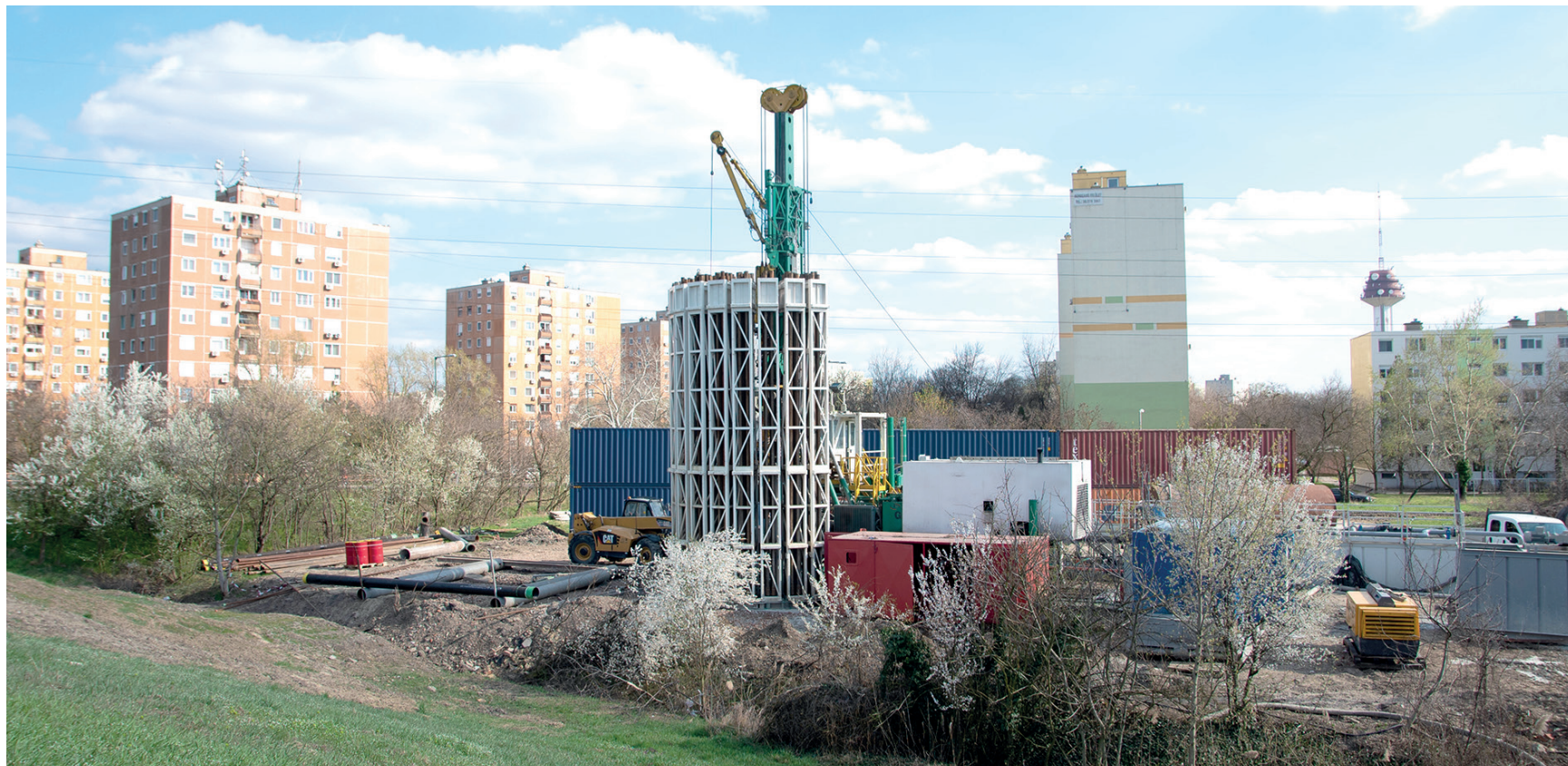
Jelenleg a Csongrádi sugárút végén, a töltésoldalon fúrják a termálkutat. Az Északi városrész hőközetének geotermikus fűtési rendszerével előreláthatóan szeptemberre lesznek kész. Fotó: Szabó Luca
