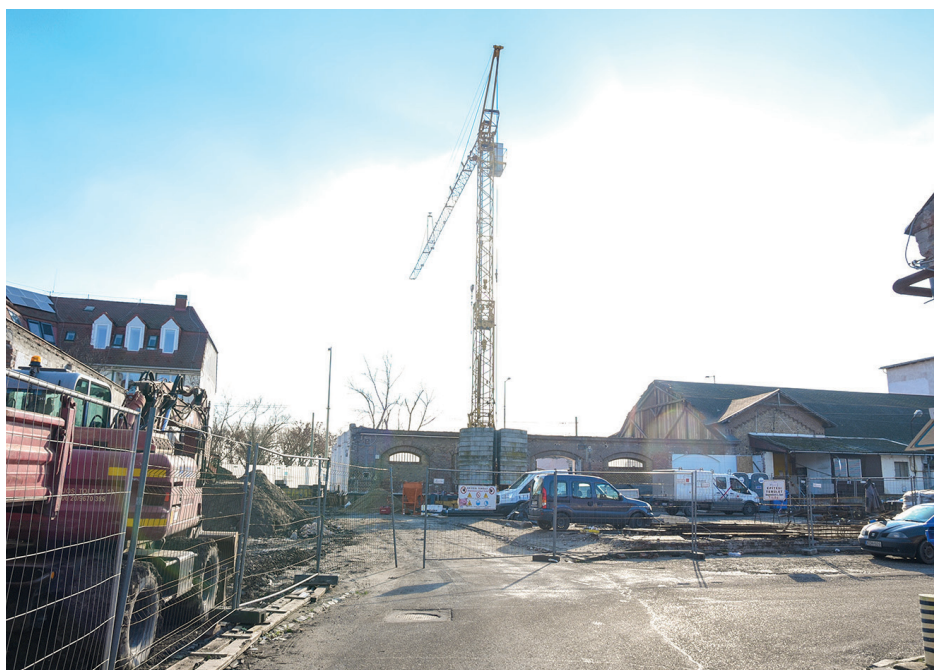
A Sóház főépületének homlokzatait meghagyják, a melléképítményeket pedig visszabontják, helyükön zöldterületeket, játszóteret, parkolókat alakítanak ki. Fotó: Szabó Luca
