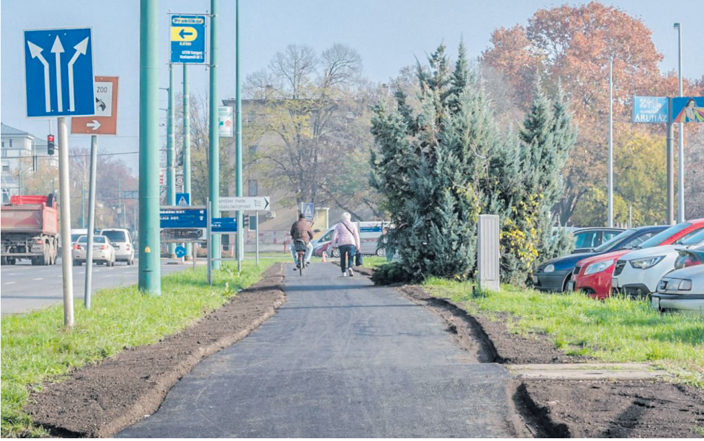
A Kálvária sugárúti kerékpárút nagykörúton kívüli részén már az utolsó simításokat végzik.
