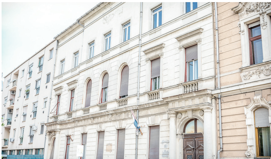
Felújítás után, másfél év múlva óvoda, általános iskola működik majd a Kálvin téri épületben. Fotó: Iványi Aurél
