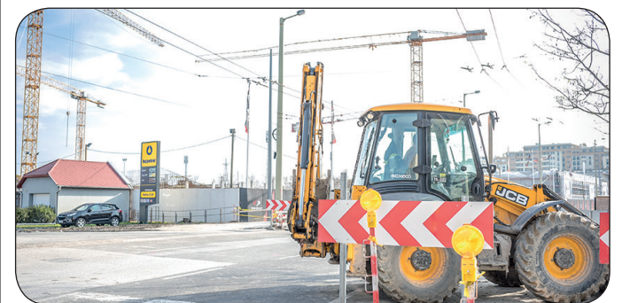
Jelenleg az új körforgalom építéséhez szükséges közműkiváltásokat végzik. Fotó: Iványi Aurél
