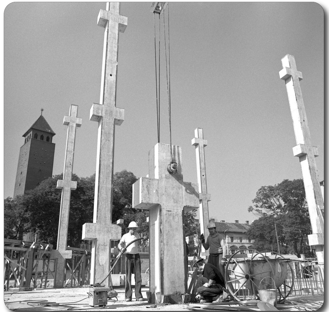
Hatalmas keresztet. A Nagyáruház tartópilléreit állítják fel 1978-ban. Somogyi Károlyné felvétele
