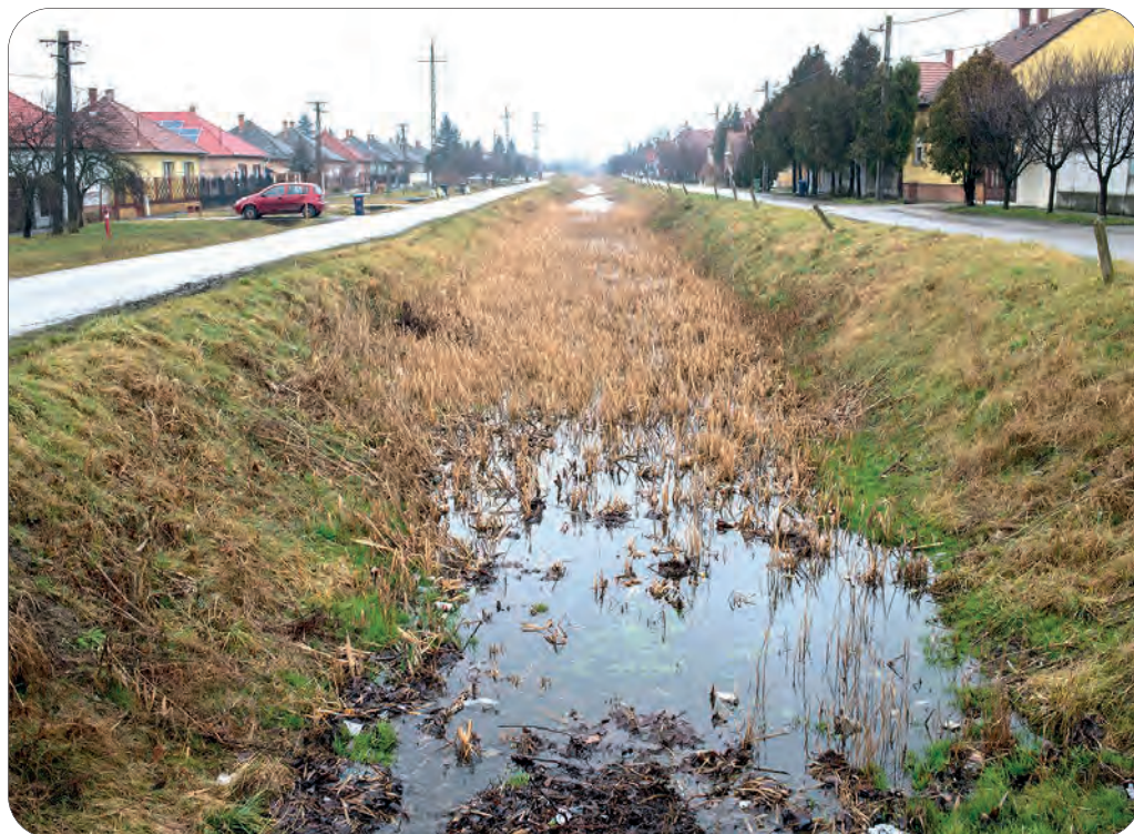
Befedik Tápén a csatornát a Muskátli utcától a Rév utcáig. A csapadékvizet egy 80 centiméter átmérőjű vasbeton cső vezeti majd el.
