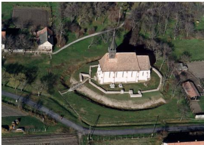
Óföldsék, Római katolikus erődtemplom
